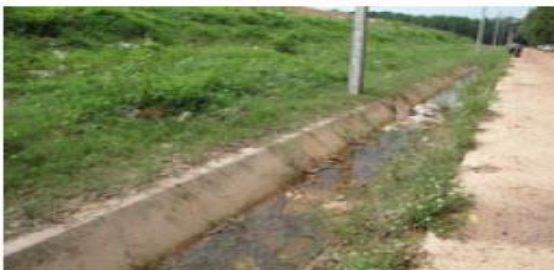
รางระบายน้ำฝน
